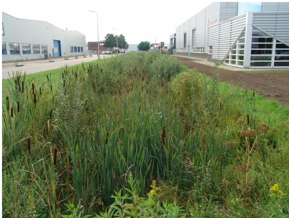
Wadi's helpen bij het opvangen en vasthouden van het regenwater en ontlasten het riool
