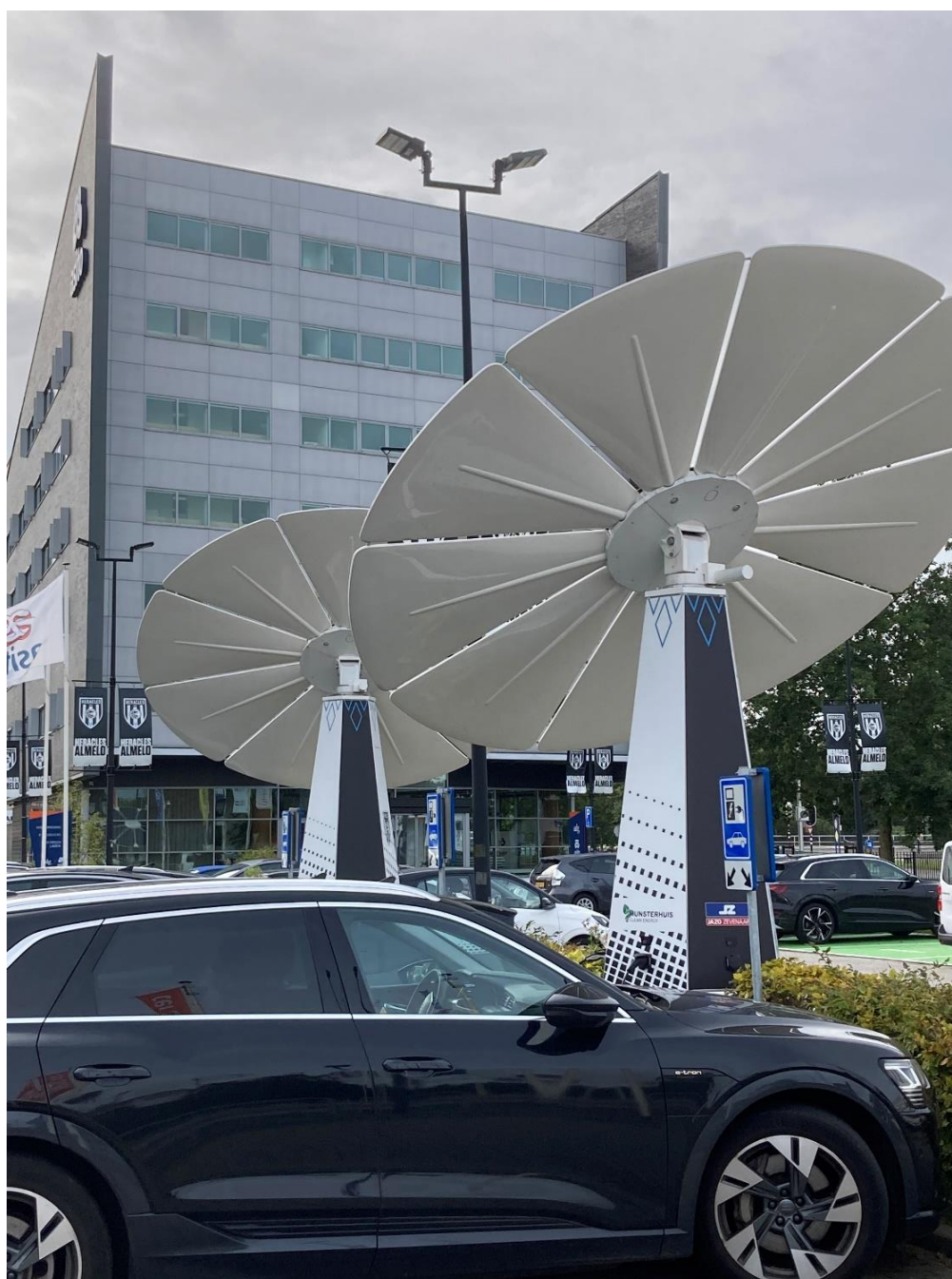
Parkeerplaats bij Heracles Almelo is een laadplein met zonnecollectoren
